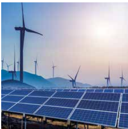
SOLUTIONS ÉNERGÉTIQUES INNOVANTES POUR PARCS & BÂTIMENTS
