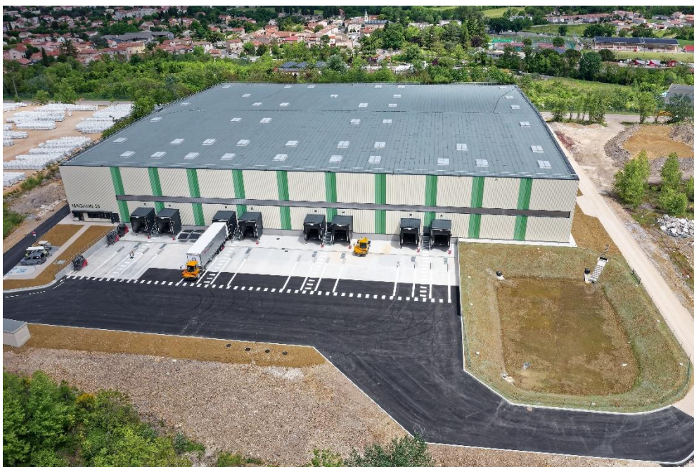
Axens – Salindres (30) – Vue extérieure drone de l'entrepôt @Cyrille Dubrueil pour Groupe Idec
