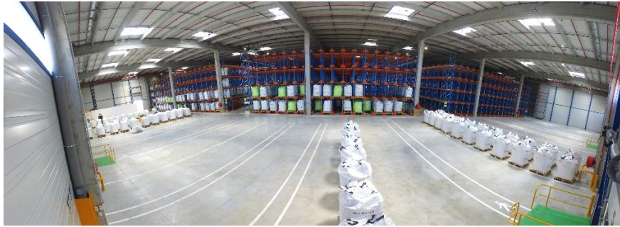
Axens – Salindres (30) - Intérieur de l'entrepôt @Enlaps pour Groupe Idec
