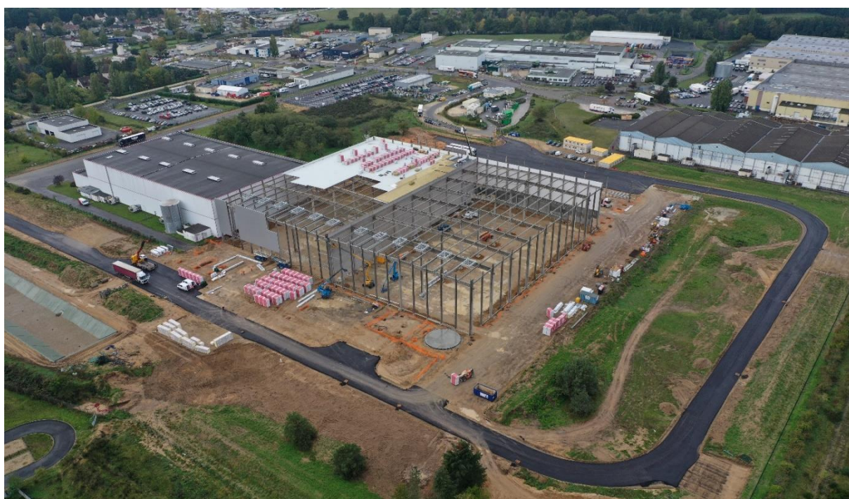
Chantier Groupe Lsdh à Châteauneuf-sur-Loire (45) – Crédit image : Jocelyn MEYNARD pour IDEC AGRO & Factory
