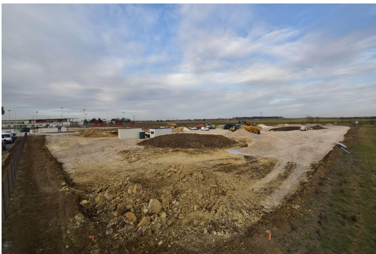
Photo du chantier EUROGERM – Crédit image : GROUPE IDEC
