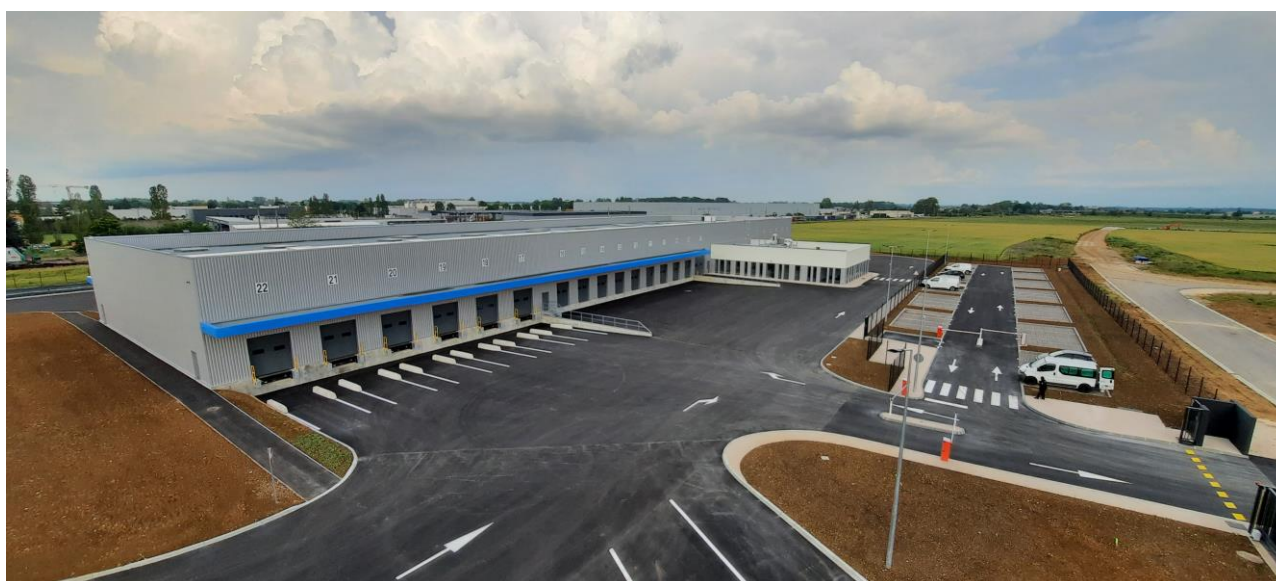
Messagerie Ciblex et Eurotranspharma à Dijon (21) – Façade extérieure - @ Crédit photo : IDEC
