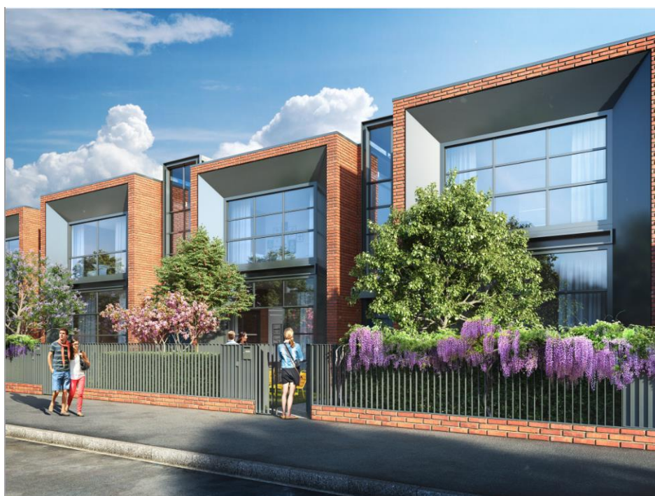
Vue Rue Esprit Loft à Deauville Architecture © Jean-Michel WILMOTTE – 3D © Kreation
