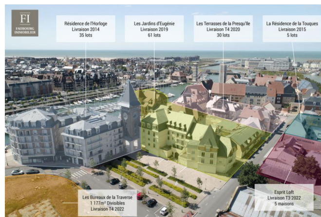
Vue Drone légendée projet La presqu'île développé par FAUBOURG IMMOBILIER à Deauville Photo @ Dany Caprais pour Alea – Illustration @ Groupe Idec
